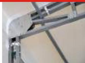
I correnti di falda delle capriate sono costituiti da doppi profili, solidamente collegati fra loro. Ciò permette di avere sezioni molto efficienti dal punto di vista statico. Inoltre la possibilità di inserire all'interno dei profili i distanziali e le diagonali e consente di realizzare una struttura corrispondente ai modelli di calcolo.
