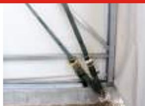
Diversamente dai competitor, per tensionare e ancorare la copertura in PVC al suolo ci si avvale di robuste cinghie di trazione certificate e marcate CE con carico di rottura pari a 5000 kg. Totalmente esenti da problemi di corrosione, sono molto semplici da tensionare periodicamente e hanno un'elevata tenacità, per evitare rotture improvvise.
