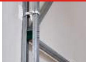
I montanti sono costituiti da due profili accoppiati, per avere sezioni resistenti e soprattutto rigide. Si aumenta così l'inerzia statica, riducendo la deformabilità dei montanti stessi. Tra i profili vengono inserite le diagonali, i distanziali delle strutture e, in basso, la ruota con gli agganci per il sistema antideragliamenti.
